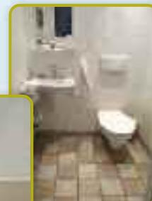
Das WC wurde erhöht und mit Stützklappgriffen versehen. Das Waschbecken ist unterfahrbar.
